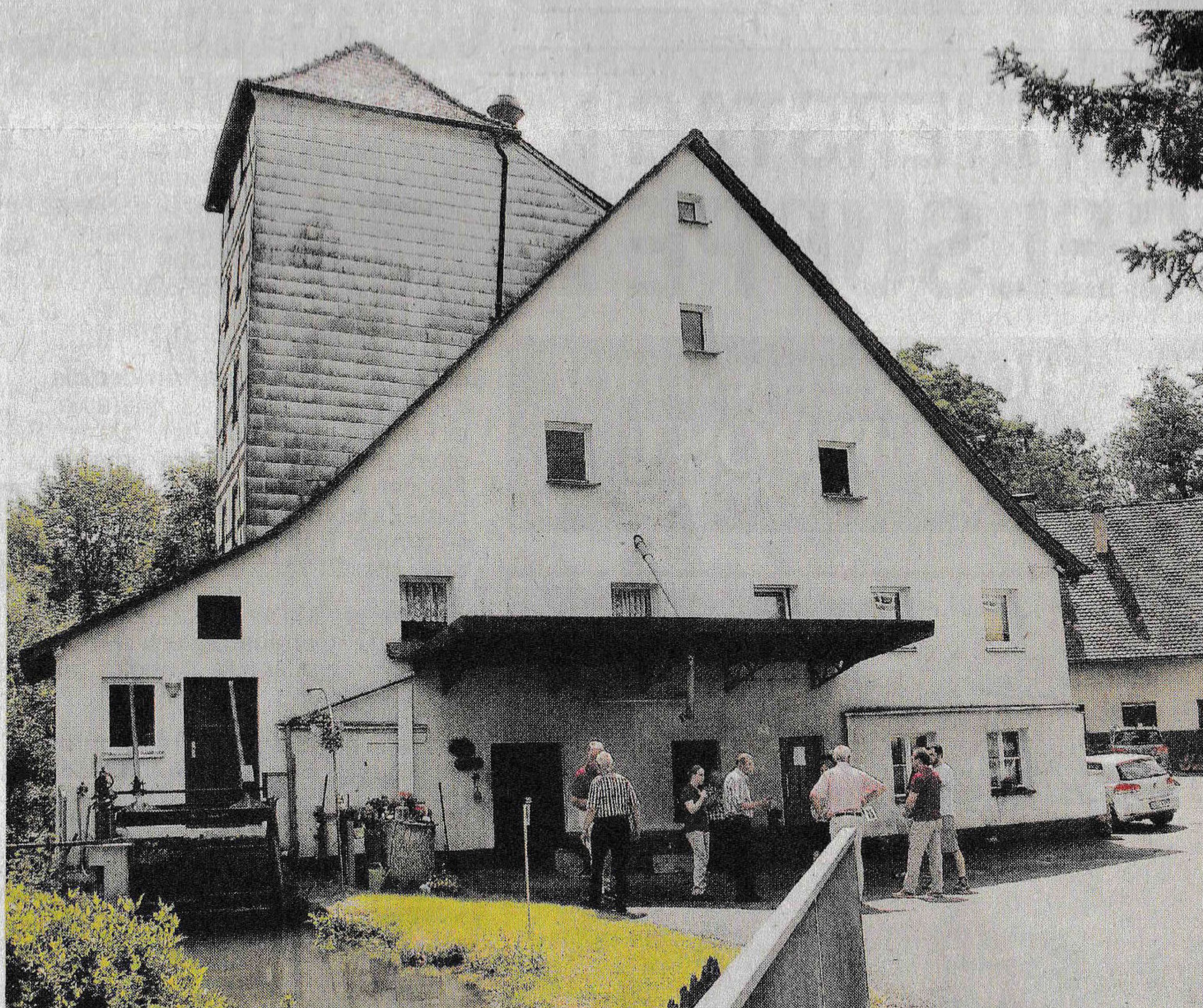
Das mehrstöckige Mühlengebäude liegt am Oberlauf der Schnaittach, die Wasserkraft treibt heute noch eine Turbine an, in der Mühle wird Getreide aus eigenem Anbau vermahlen.
